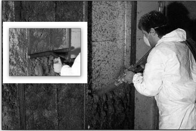
Raclage du produit projeté avec port de masque.
