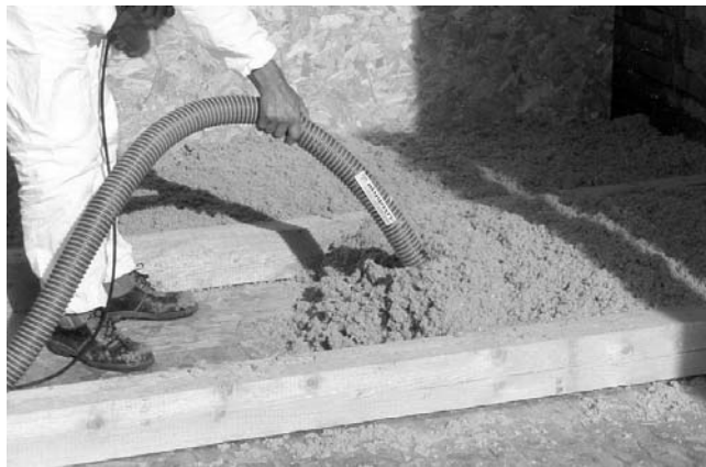
Figure 1 : soufflage sur planchers de comble
